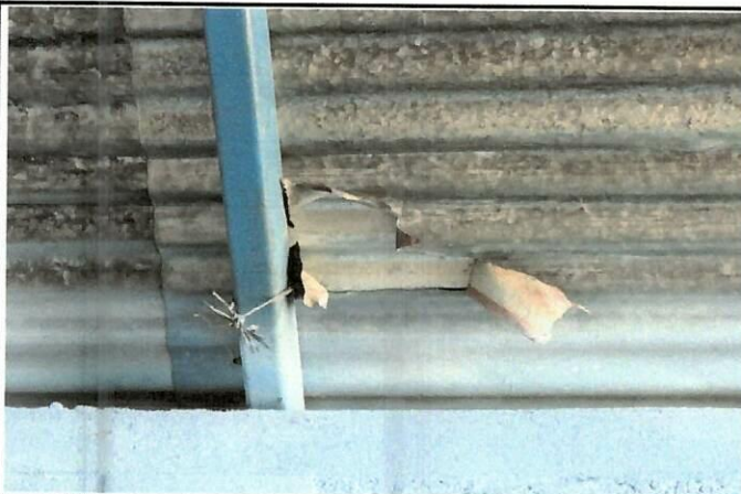
Foto 3: Esto evidencia que la lamina del techo esta totalmente roto por la falta de cambio de parte del MINEDUC
